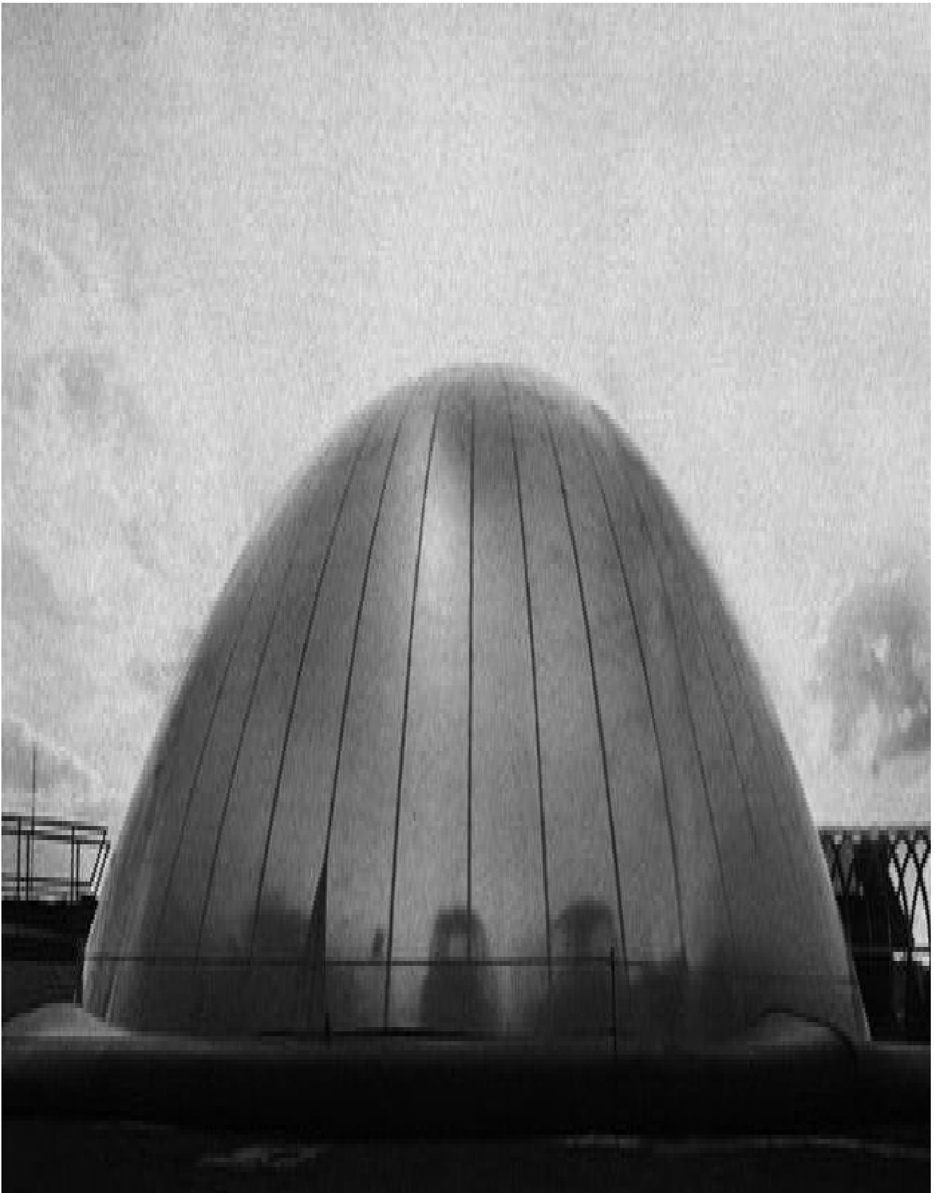
Axel Thallemer para Festo Corporate Design, Airquarium , 2000 (32 m de diámetro, 8 m de altura). Se estabiliza mediante un depósito de lastre alrededor.
