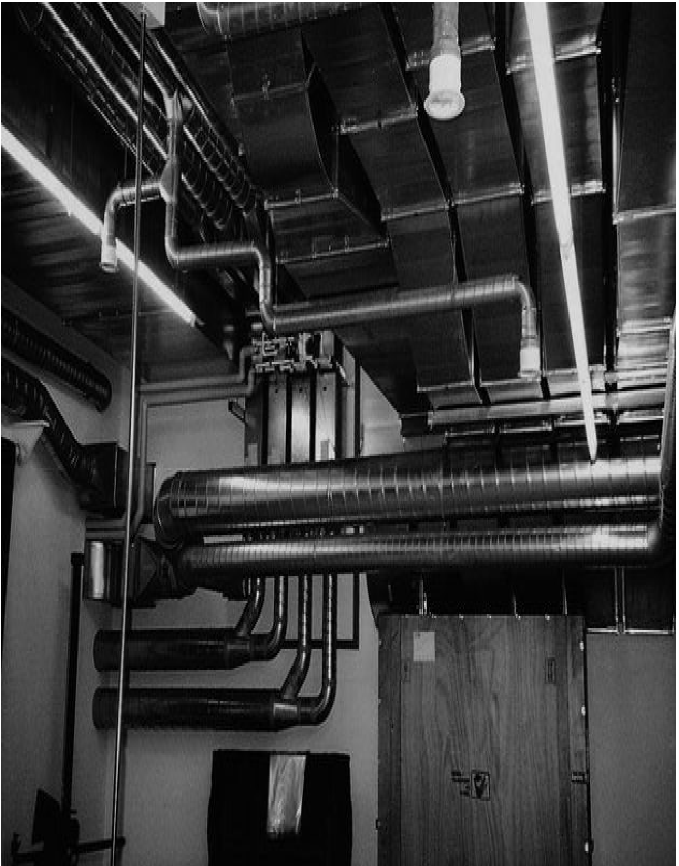
Vista parcial de la instalación de aire acondicionado del Museo de la Fundación Beyeler en Rieten, cerca de Basilea, de Renzo Piano, 1997.
