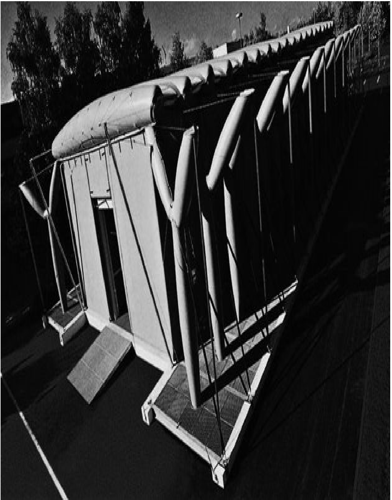
Axel Thallemer para Festo Corporate Design, Airitecture Hall , 1996. Vigas de cubierta llenas de aire y soportes laterales en forma de Y, material: cobertura de vitroflex.
