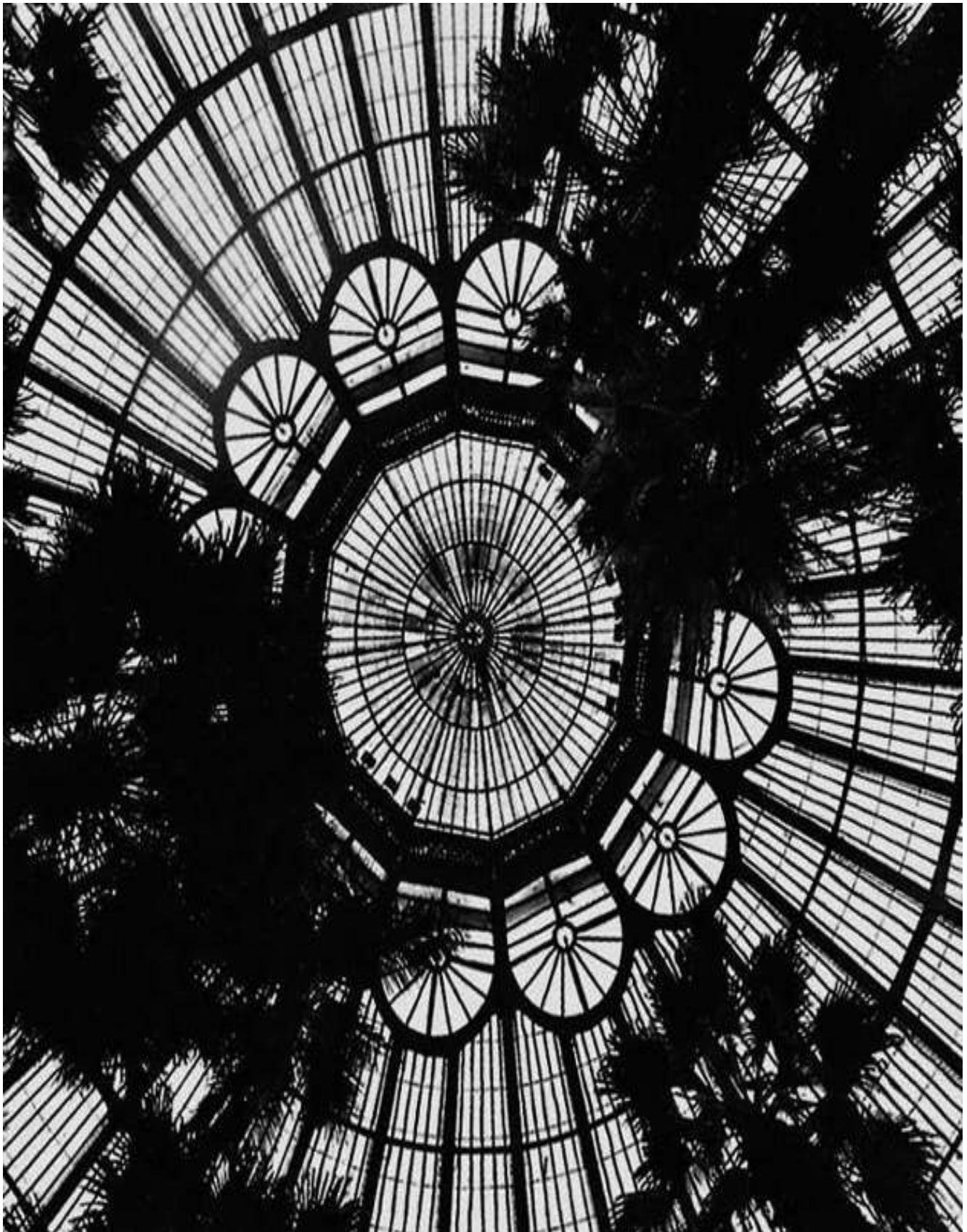
Vista de la estructura del tejado.
